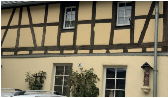
Positiv: renovierte Fachwerkfassade
