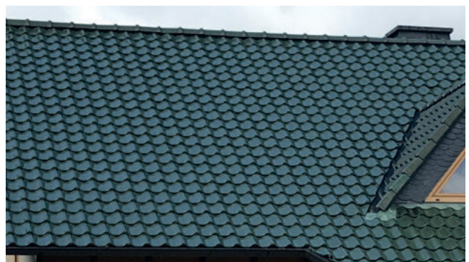
Negativ: Dacheindeckung mit glasierten grünen Ziegeln
