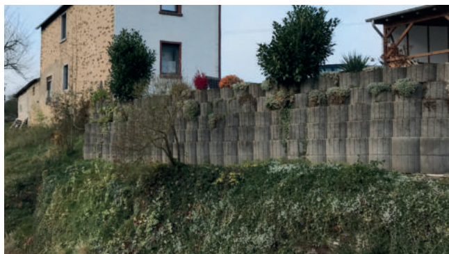
Negativ: Stützmauer aus Betonsteinen
