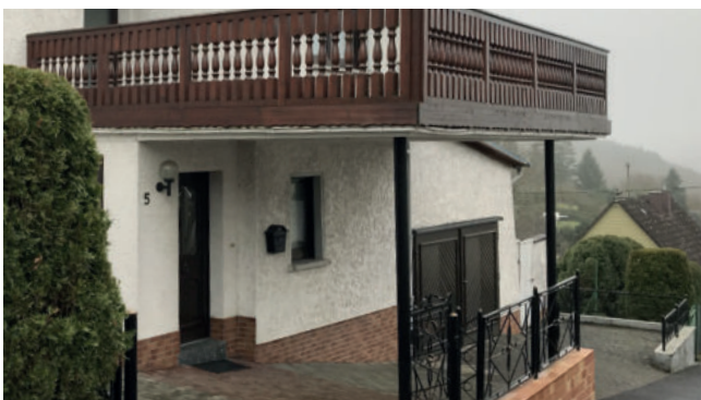
Negativ: im Vergleich zum Hauptgebäude überdimensionierter Balkon
