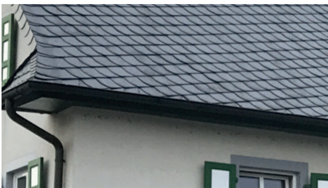
Negativ: überdimensionierter Dachüberstand (ortsuntypisch)
