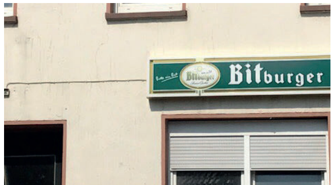
Negativ: Werbeanlagen mit offenliegenden Kabeln
