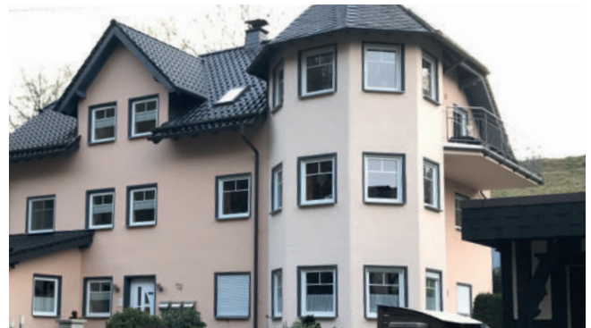
Gestalterische Disharmonie, Turm wirkt überdimensioniert
