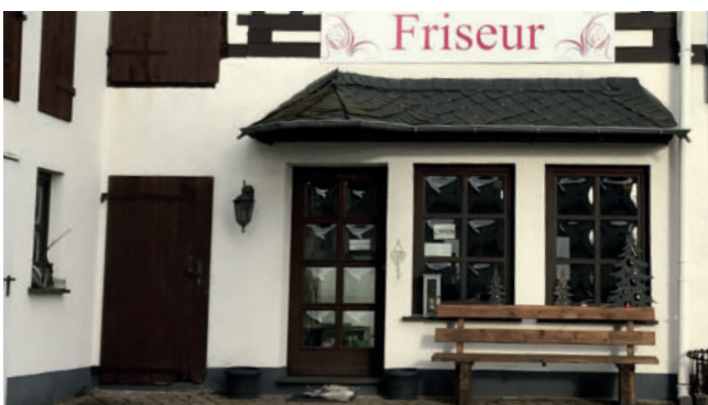
Positiv: Schaufensterelemente sind an die Fassade angepasst
