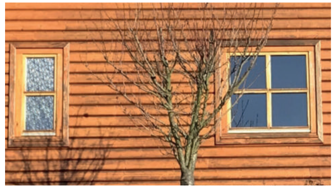
nicht bescheinigungsfähig: mit Blockhausprofil verkleidetes Wohnhaus
