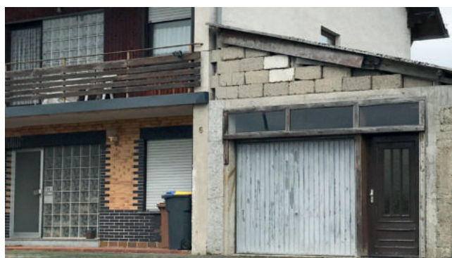
Negativ: angebauter Carport ohne Bezug zum Hauptgebäude
