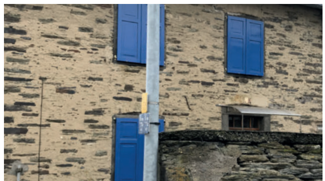
aufdringliche Farbgebung (Fensterrahmen, Klappläden)
