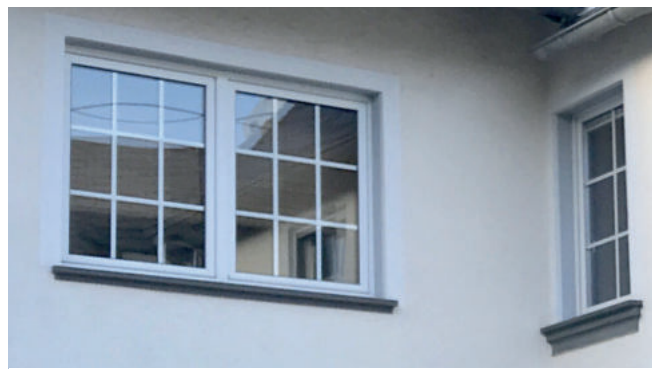
Negativ: aufgeklebte Fenstersprossen
