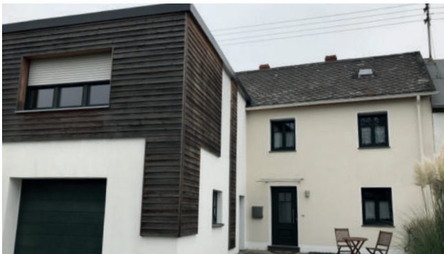
Gestalterische Disharmonie zwischen Hauptgebäude und Anbau
